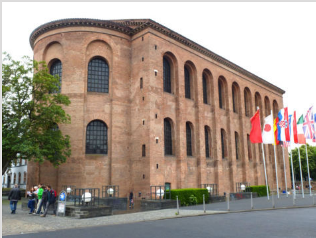
Die Konstantinbasilika in Trier, ursprünglich eine Audienzhalle für den römischen Kaiser, ist Teil des UNESCO-Welterbes. Vom Bautyp her ist sie eine Saalkirche. Heute wird sie als eine evangelische Kirche genutzt. In einer der Fensternischen befindet sich eine Orgel. Foto hpb
